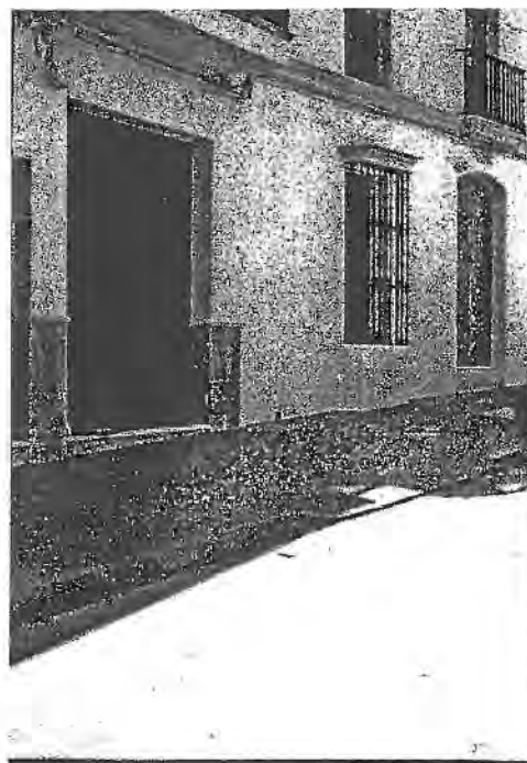
Entrada a garaje en Calle Calvario.
